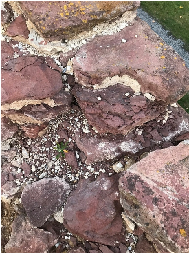
Foto 2/ Destrukce malty spárování a přilehlých kamenných bloků
